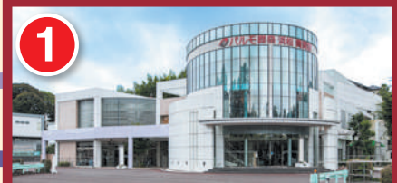
1 パルモ葬祭 浜松 貴賓館・参番館・浜松office 浜松市中央区住吉1-11-23
