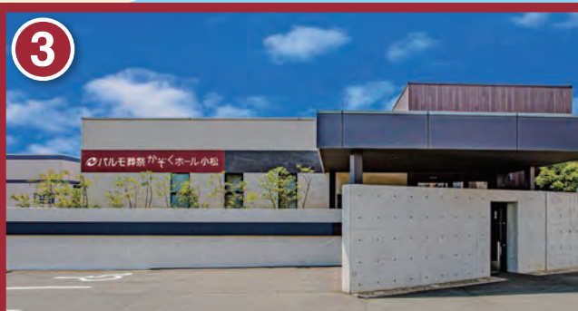
3 パルモ葬祭 かぞくホール 小松 豊橋市小松町 235
